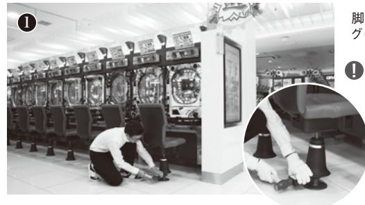
脚部カバーを上げ、アンカーベースとポールの間に取り外しジグ(M4)を差し込み、ハンマーでたたく。
