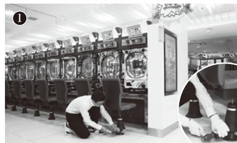
1 脚部カバーを上げ、アンカーベースとボールの間に取外しジグ(M4)を差し込み、ハンマーでたたく。
