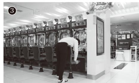
3 再度、椅子をアンカーベースに取付ける時は、シート部(ボールが付いた状態)を持ち、アンカーベースにボールを差し込む。その際、アンカーベースにボールがきちんとはまるように押し込んでください。シートをセットした後に座面に荷重をかけてシートがはずれないようにしてください。
