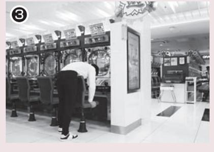
再度、椅子をアンカーベースに取り付ける時は、シート部(ポールが付いた状態)を持ち、アンカーベースにポールを差し込む。その際、アンカーベースにポールがきちんとはまるように押し込んでください。シートをセットした後に座面に荷重をかけてシートがはずれないようにしてください。
