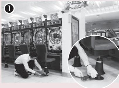
脚部カバーを上げ、アンカーベースとポールの間に取り外しジグ(M4)を差し込み、ハンマーでたたく。
