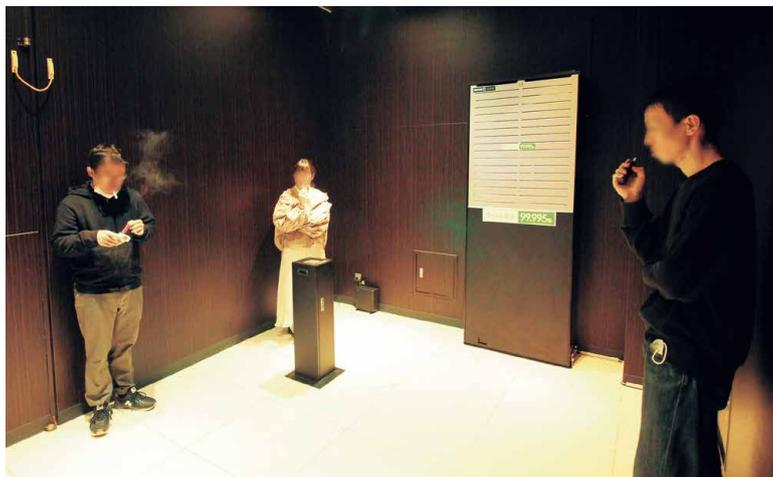
「スモーククリア エアクリンW」によって喫煙室内の空気環境を大幅に改善。快適な喫煙環境を創出する。また、100V電源があれば簡単に設置できる点も特徴だ。
