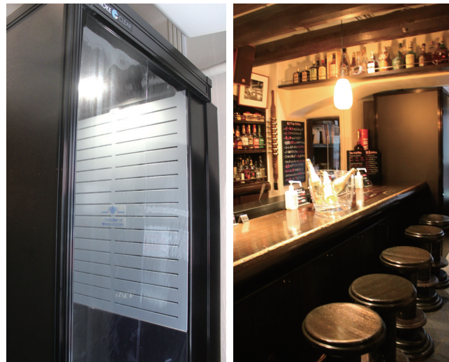
スモーククリアスマートミニは、店舗奥の遊休スペースに設置。入り口を窓側に向け、カウンターに背面を付けて設置しているため、客席からは壁面のように見える（左が窓側から見たもの、右が客席から見たもの）
