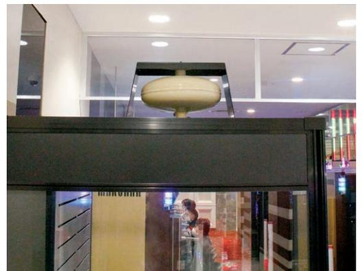
『スモーククリア』の天井に取り付けた簡易消火機器。設置もエルゴジャパンが担当する
