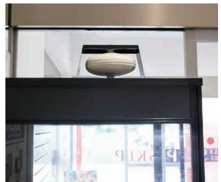
天板上に取り付けた簡易消火機器。設置はエルゴジャパンが担当する
